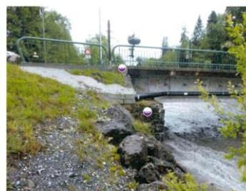
Figure 5 : Localisation des repères sur le pont de Verchaix (rive droite, côté aval)
