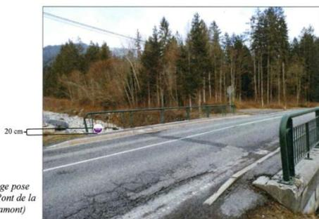
Figure 3 : photomontage pose repère de crue D907 – Pont de la Valentine (vue vers l'amont)
